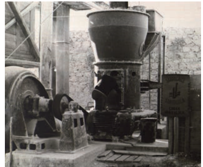
Sardo Calce srl a Siniscola (Nuoro), insaccatrice e impianto per la calce idraulica, 1954 (fotografo sconosciuto) Pratica 981
